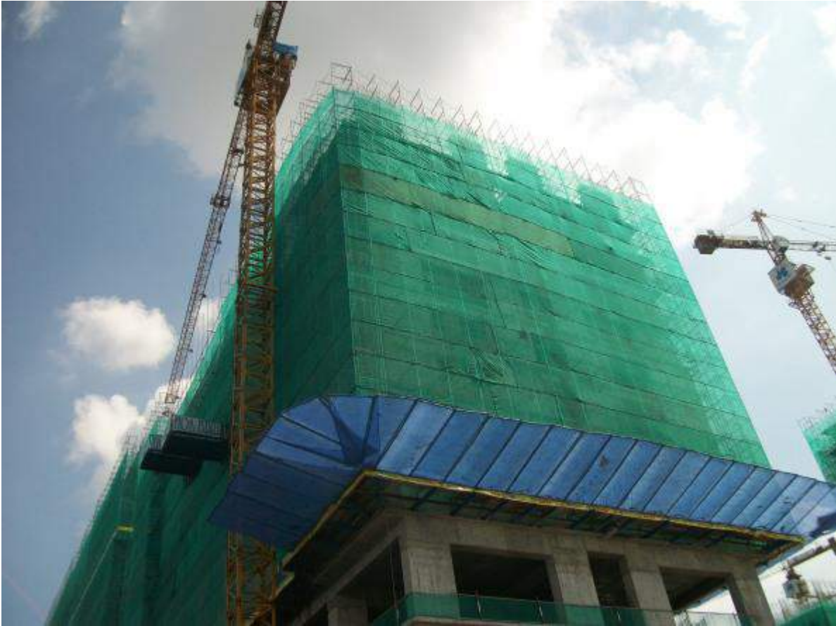
Hình IV.1: Biện pháp che chắn công trình ngăn phát tán bụi ra môi trường khi thi công xây dựng
